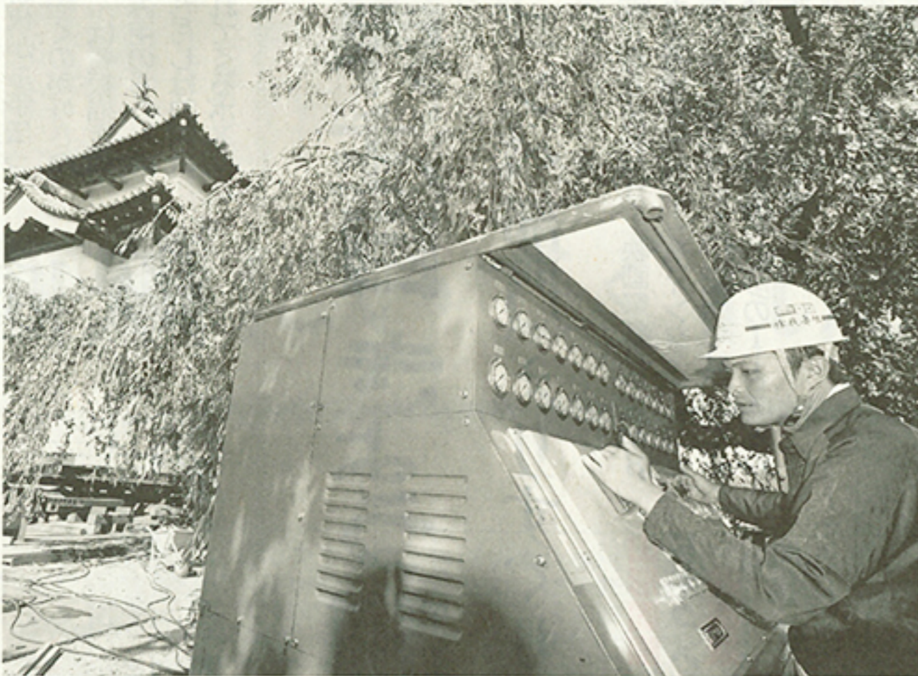
油圧式ジャッキの制御盤を操る石川憲太郎さん。使命感を胸に職人を率いる ＝青森県弘前市・弘前城本丸
